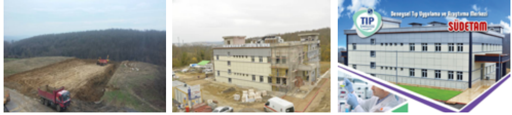
Resim 8. SÜDETAM temel atma, inşaat ve son hali
