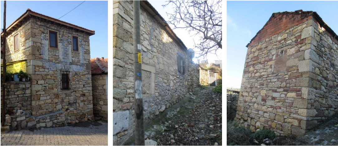
Şekil 7. Özgün boyutu değiştirilen veya tamamen kapatılan açıklıklar
