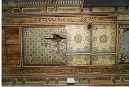
Fotoğraf 15. Mahfil tavanı üstünde yer alan bezemeler ve muşamba, Güryapı Fotoğraf Arşivi.
