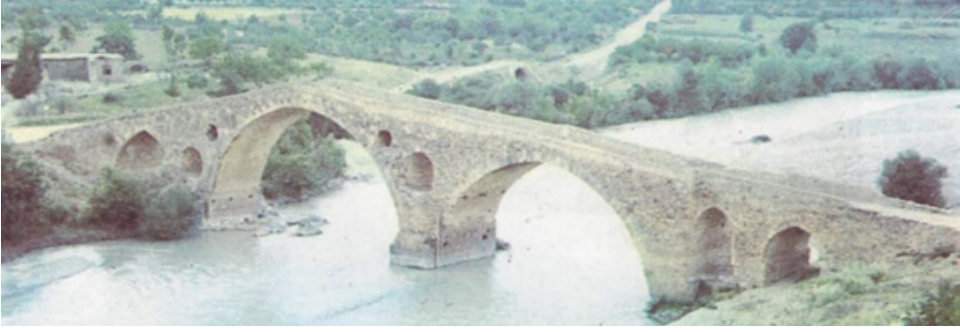
Fotoğraf 1: Gravga Köprüsü mansap cephesi, 1970'li yıllar. (güney↔ kuzey) (İlter, 1978.)
