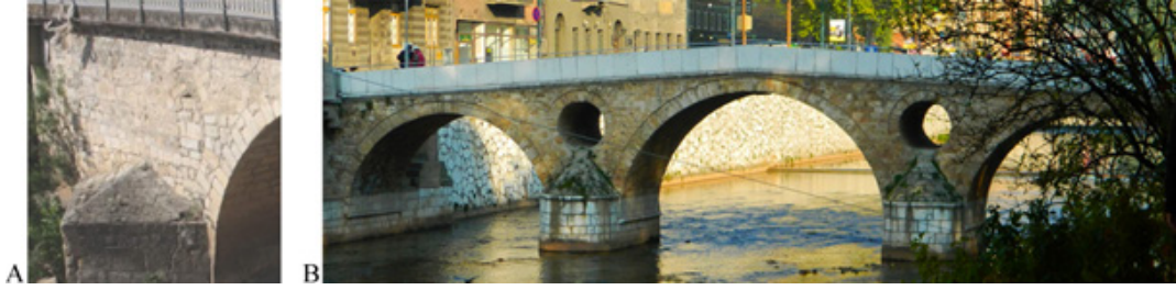
Fotoğraf 11: A) Göksu (Kadı) Köprüsü selyaranı. (Dayar, 2017, s.47) B) Bosna-Hersek, Sarajevo'da "Latin Köprüsü", 2015. (Latin Bridge, 2023)
