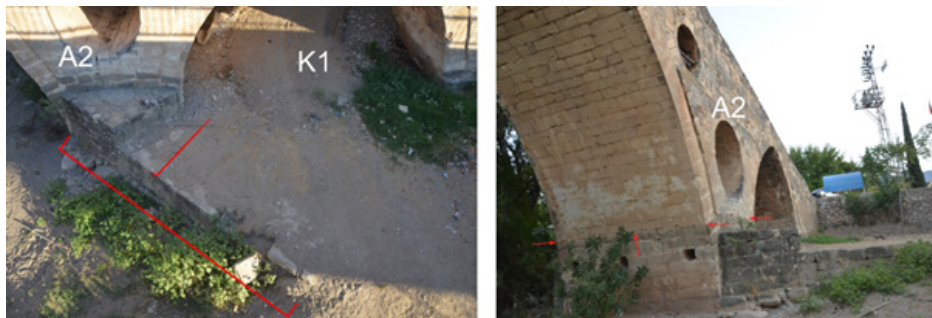
Fotoğraf 7: Gravga Köprüsü, A2 ayağı, koruma duvarı, platform ve onunla bütünleşik selyaran. (Menba tarafı. 2020)
