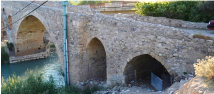
Fotoğraf 3: Gravga Köprüsü mansap cephesi, kuzey bölümü. (2020)
