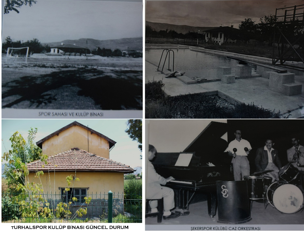
Şekil 9. Turhal Spor Kulüp Binası (Turhal Şeker Fabrikası Arşivi, 2022).
