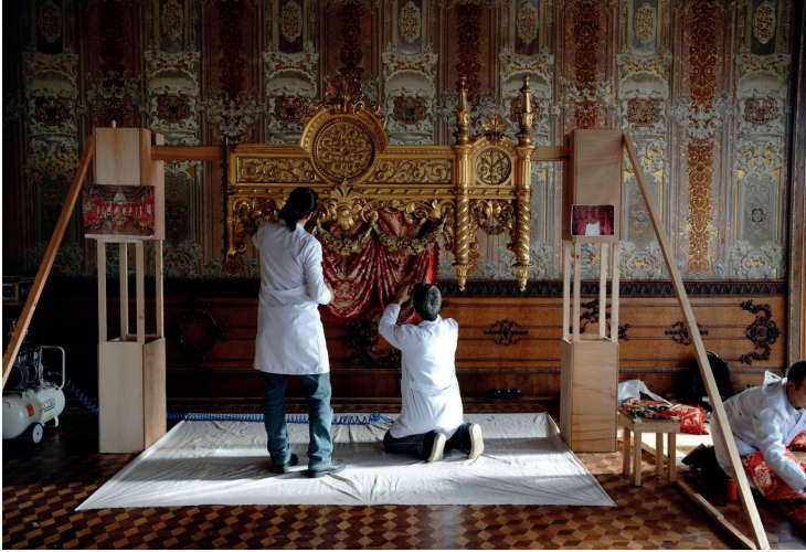
Resim 5: Dolmabahçe Sarayı Süferâ Salonu restorasyon çalışmaları
