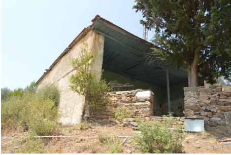
Fotoğraf 2: Mesken Orta Mahalle Cami Güneybatı Cepheden Görünüm (N. Bahargülü)
