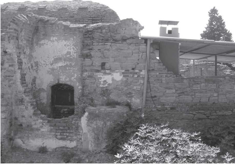
Resim 18 : Kuzey kanadındaki hamamın batı cephesinden kısmi görünüş.
