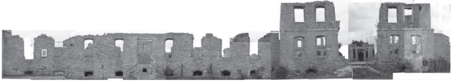
Resim13 . (Güney kanadı) Kuzey cephesi kısmi görünüşü.
