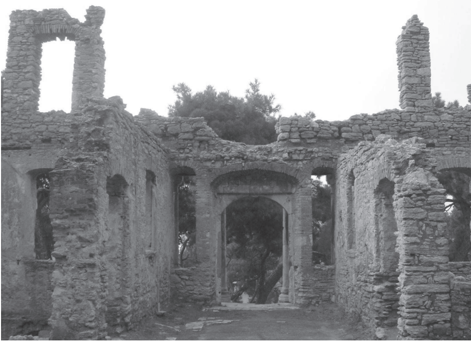
Resim 10 : Güney kanadın güney cephesindeki giriş kapısına bina içinden bakış.
