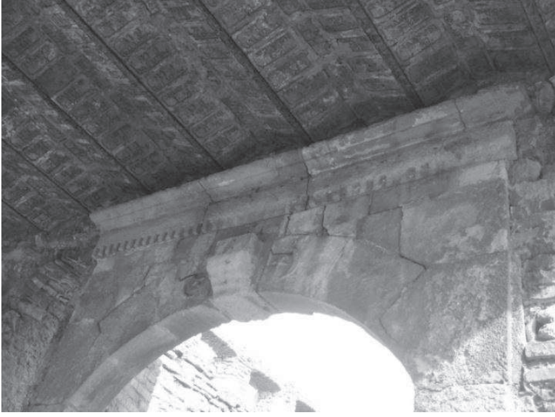
Resim 6 : Güney kanadın güney cephesindeki giriş kapısı kısmi görünümü.
