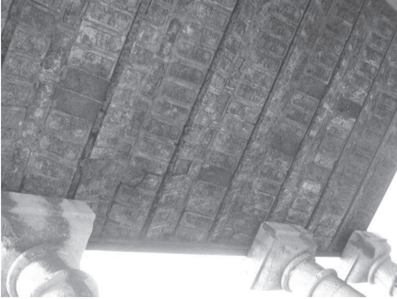
Resim 7 : Güney kanadın güney cephesindeki anıtsal giriş ait kolon başlıkların kısmi görünümü ve 'MYDOS' damgalı tuğlalardan oluşan volta döşeme.
