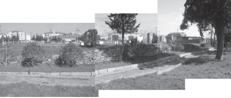
Resim 17 : Bomba etkisiyle en fazla tahribatın olduğu kuzey kanadı görünüşü.
