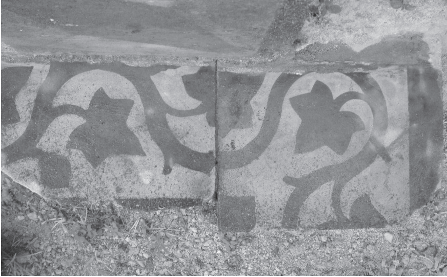
Resim 11 : Hastane ana giriş mahalli zeminindeki karosiman kalıntıları.
