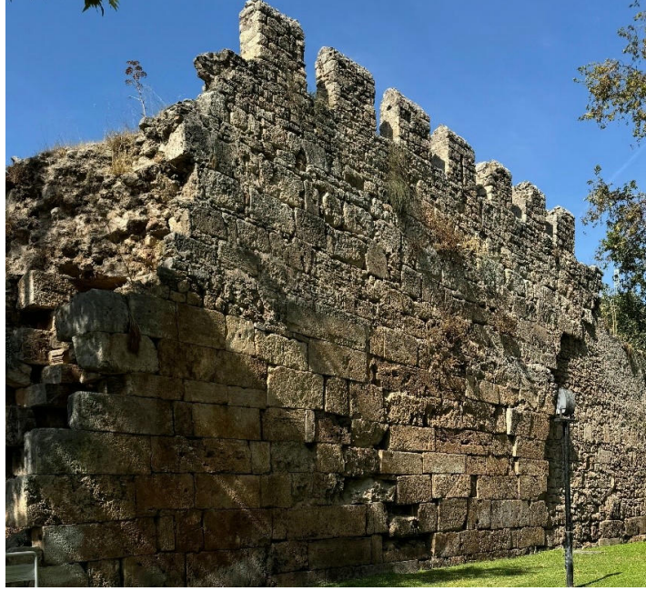
Görsel 8: Antalya Kalesi'nin doğu sur hattında yüzleme duvar inşası (2024)
