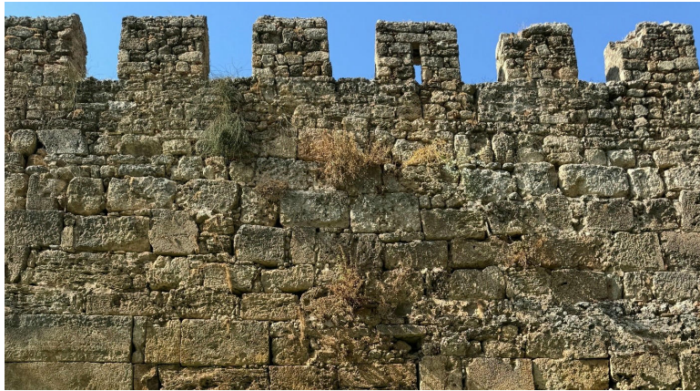
Görsel 7: Antalya Kalesi'nin doğu sur hattının günümüze ulaşan bölümünde çivileme tekniğinin izleri görülmektedir. (2024)
