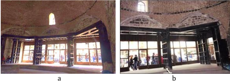
Şekil 10. (a) Hamam girişine eklenen metal malzemeli yatay ve (b) dikey taşıyıcı elemanlar (2015)
