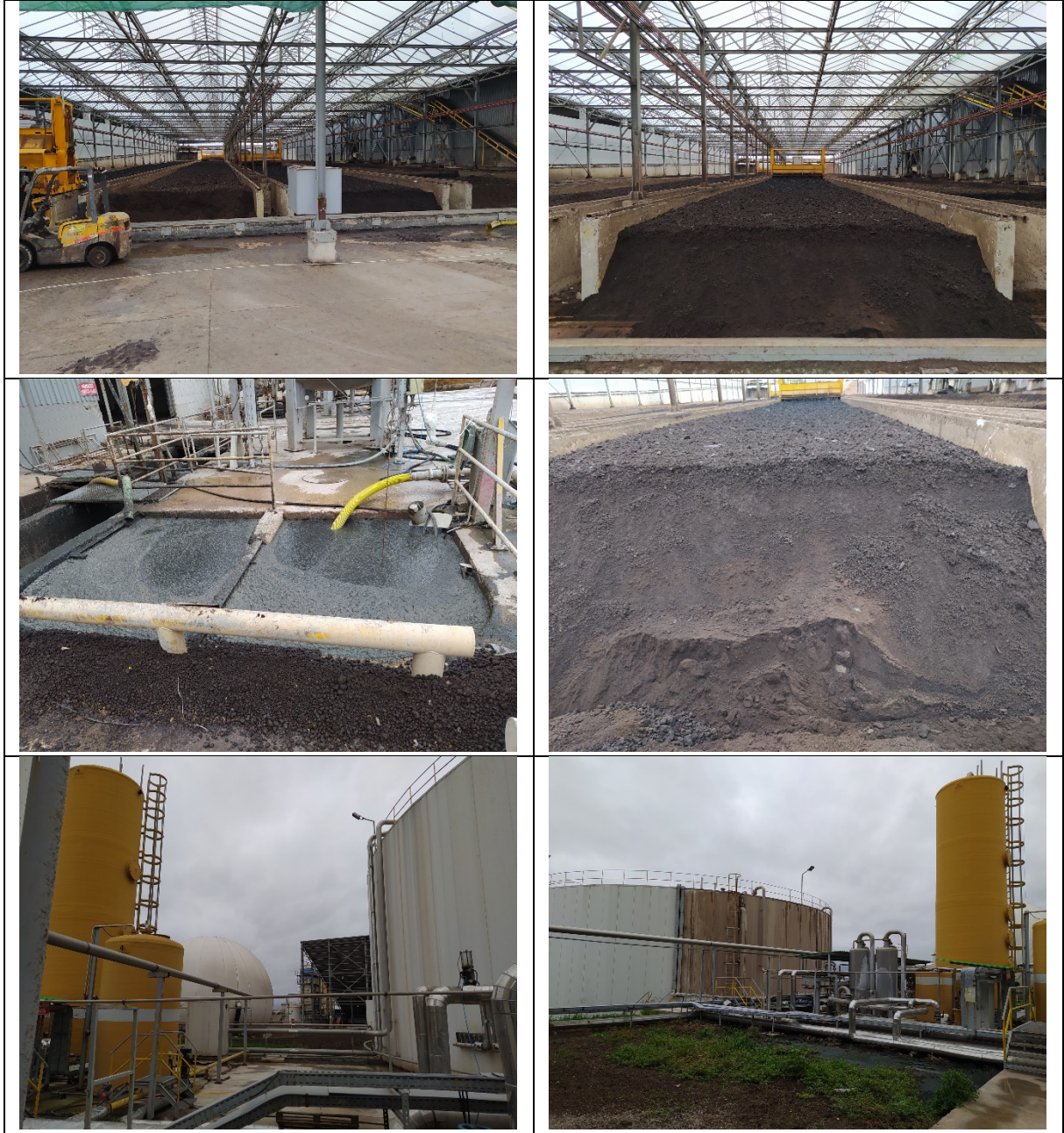
Şekil 3. Gönen ilçesinde aktif çalışan biyogaz tesisinden fotoğraflar.
