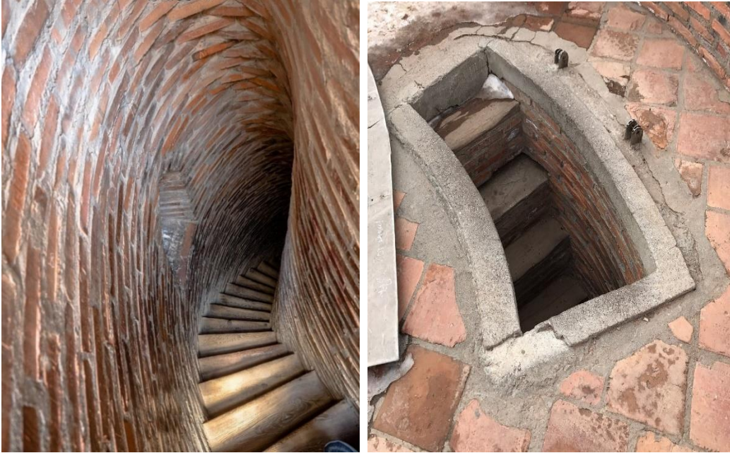
Resim 5. ve Resim 6. Burana Kulesi Merdivenleri (Tripadvisor, 2024)
