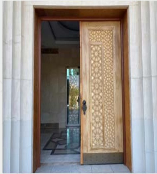
Fotoğraf 10. Yan Cephe Kapıları
