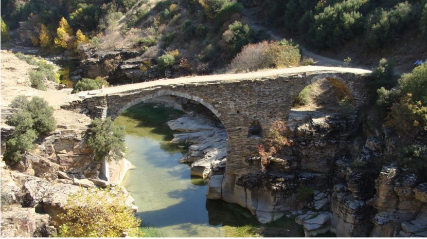
Fotoğraf 9. Deliiniş Çayı üzerinde bulunan Karahasan Köprüsü.
