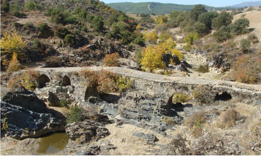
Fotoğraf 11. Gördes Çayı üzerinde bulunan Çırpılı Köprüsü.
