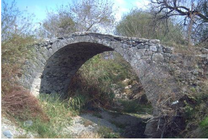
Fotoğraf 14. Gelenbe yakınında Karaağaç Deresi'nde bulunan Uzunoklu Köprüsü.
