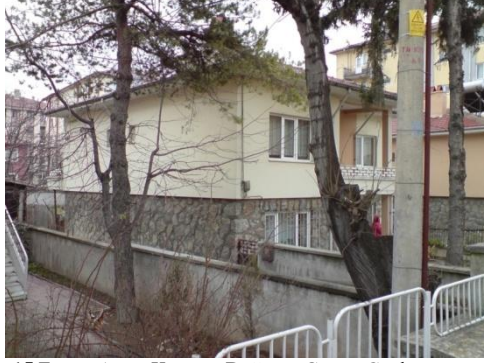
15. Fatma Argat Konutu, Doğu ve Güney Cephe
