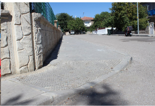
Şekil 16. Standartlara uygun rampa
