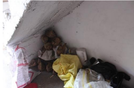
R 2: Atık Deposu
