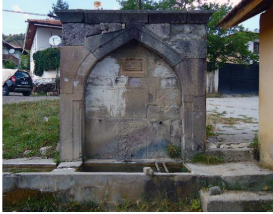
Fotoğraf 3. Belsöğüt Köyü Çeşmesi Genel Görünüm
