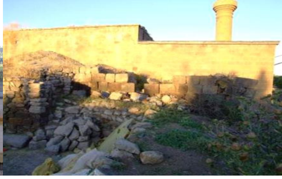
9.Mollakent Mescit Batı Cephe
