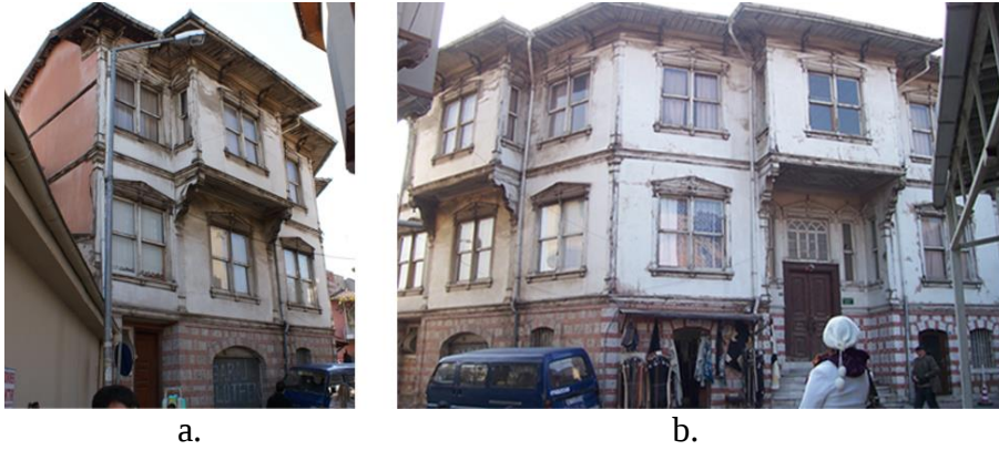
Şekil 2. a. Kuzey Batı Cephe [6] , b. Kuzey Cephe [6]
