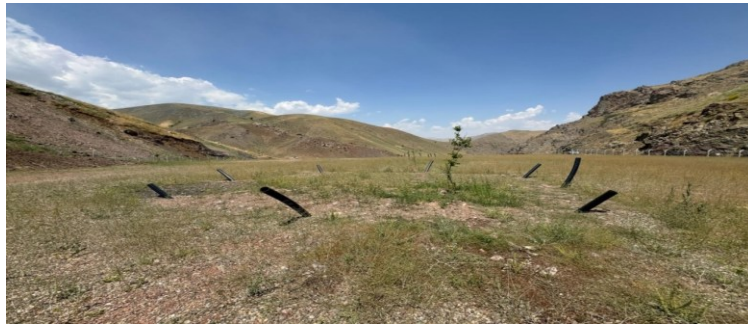
Şekil 9. Gaz tahliye boruları.
