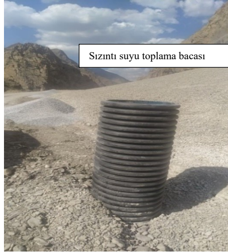
Şekil 7. Hakkari ve Yüksekova sızıntı suyu toplama bacası.
