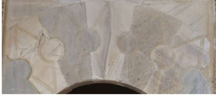
Fotoğraf 3. Sivas Gök Medrese Oda Giriş Kapısı Kemer Yalancı Geçme Örneği (Yazara ait, 2018)
