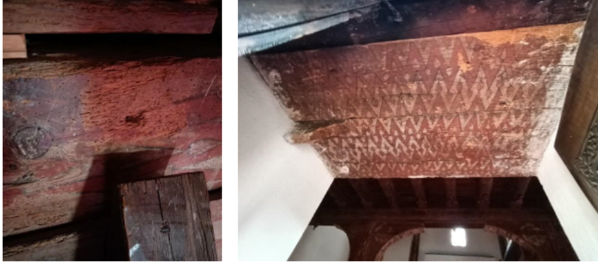
Görsel 27: Kasaba Köyü Mahmut Bey Camii mahfil döşemede oluşmuş uçma delikleri (sol), cümle kapısı lentosunun maruz kaldığı uçma delikleri ve pigment kaybı (sağ)
