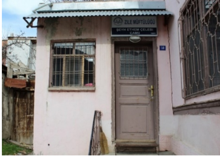
Görsel 9: Giriş kapısının görünüşü
