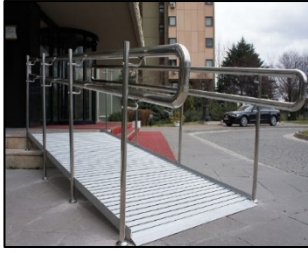
Tekerlekli sandalye kullanımı için eğimli metal rampa (URL-1)
