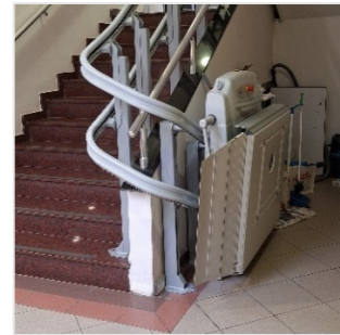
Tekerlekli sandalye kullanımı için merdiven platformu (Kocaeli Üniversitesi Personel İşleri Binası. Yazar arşivi)
