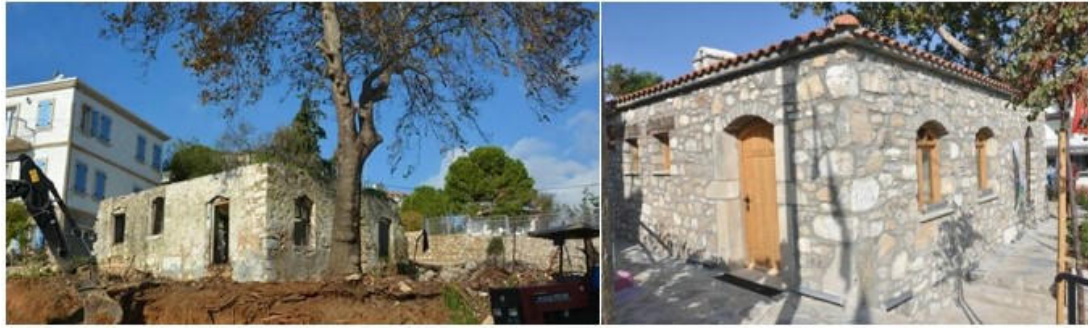
Görsel 7: Datça Cezaevi restorasyon öncesi ve sonrası
