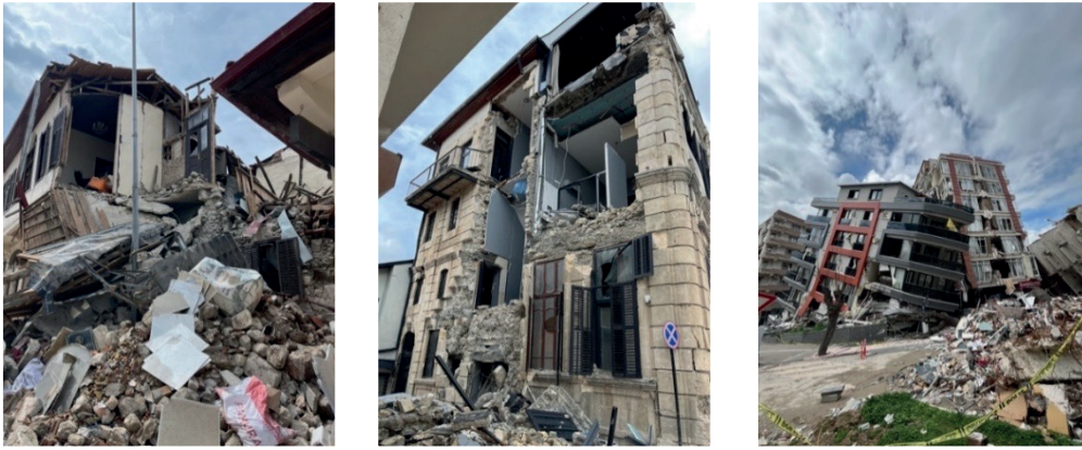
Şekil 3: Hatay’da depremin etkileri Figure 3: Earthquake effects in Hatay
