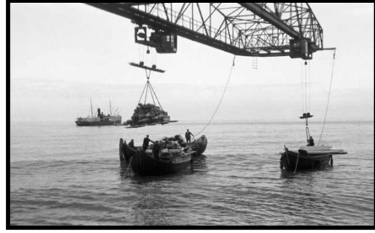
Şekil 13. Fabrika açıklarında kereste almak için bekleyen gemiler ve vinç yardımı ile mavnalara yüklenen kerestelerin gemilere ulaştırılması (Höhn&Yılmaz, 2013)
