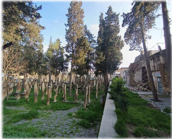
Görsel 13e: Hazireye Bakan Kısımdaki Hanelerin Yıkılan Duvarları, Ulu Cami.
