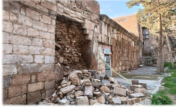
Görsel 5b: Cami Avlusu ve Hazire İçine Çöken Duvar, Ulu Cami.
