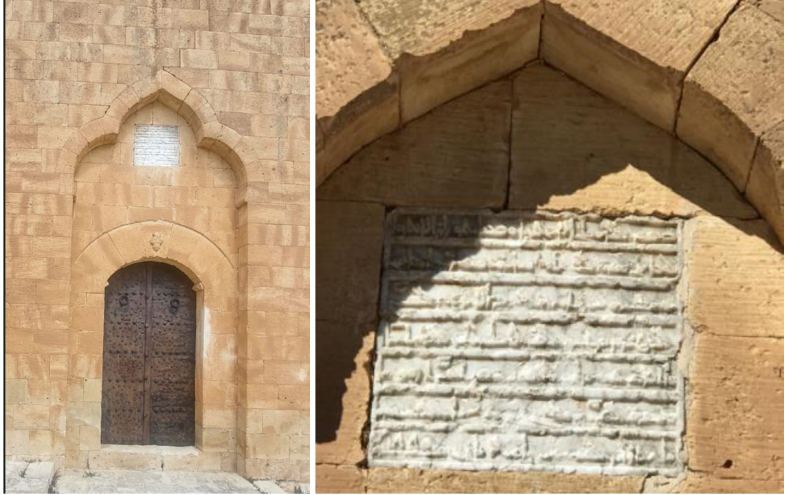
Şekil 5: Mor Cercis Kilisesi Güney yönünde bulunan giriş açıklığı ve onarım kitabesi (Yazar, 2024)
