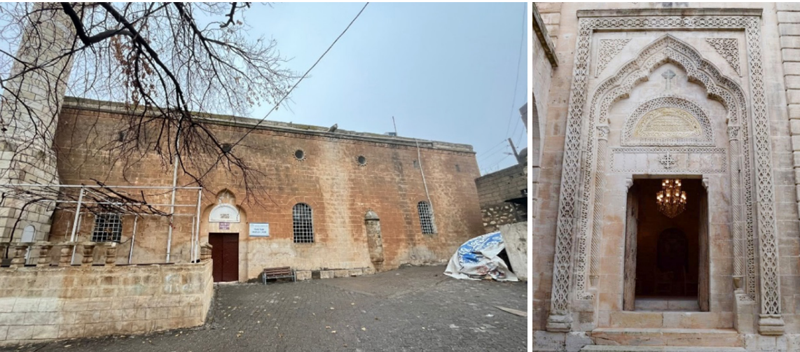
Şekil 12: Mor İsyo Kilisesi (Şeyh Mansuri Cami) giriş açıklığı ve güney cephesine bakış (sol) ve giriş açıklığına yakın çekim (Yazar, 2024).
