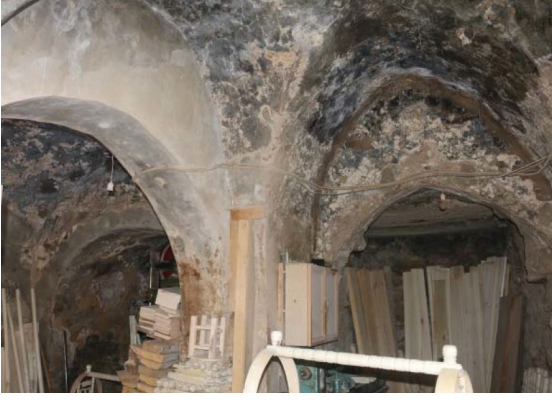
Fot. 15, 16: Dükkanların Örtü Sisteminden Örnekler.
