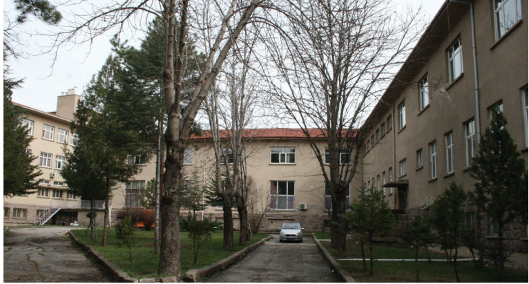
Res. 17: A Blok batı cephesi.
