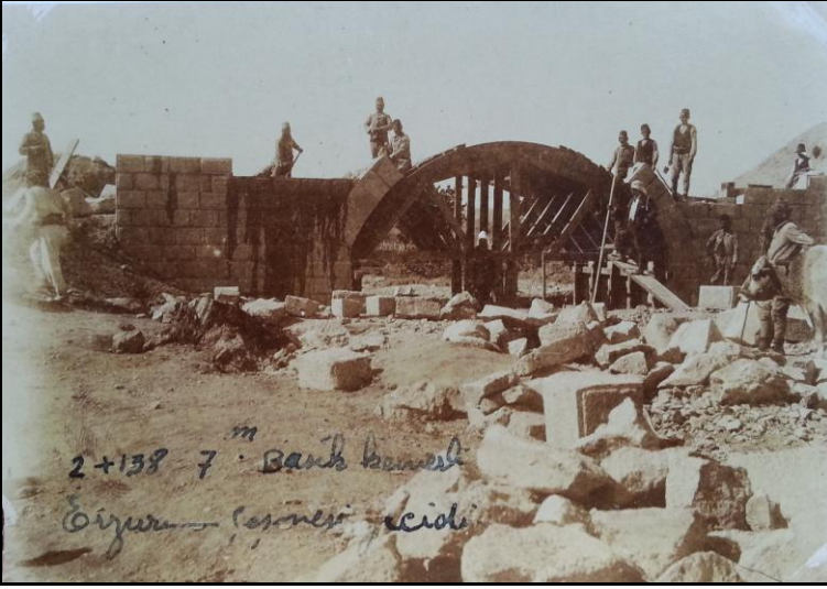
Erzurum Çeşmesi-Tren yolu geçidi (bugünkü Kurtuluş demiryolu köprüsü) (1914)
