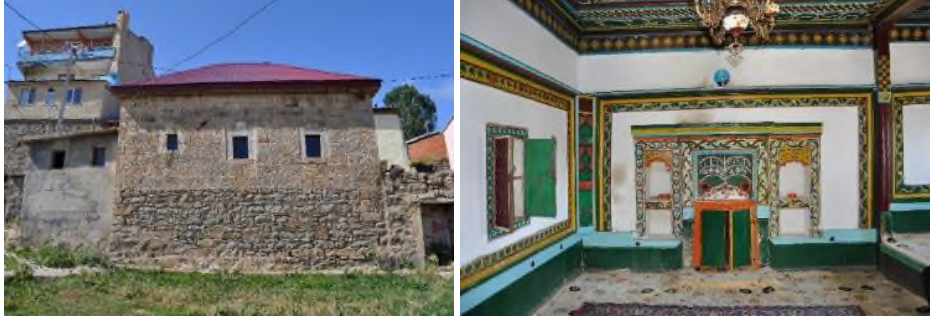
Görsel 5. 2 Nolu Köy Odası, kuzey cephesi ve iç mekânı, 2021
