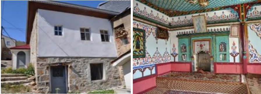
Görsel 1. 1 Nolu Köy Odası, kuzey cephesi ve iç mekânı, 2021
