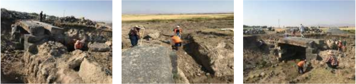
Şekil 9. Kız Köprüsü - Muş
