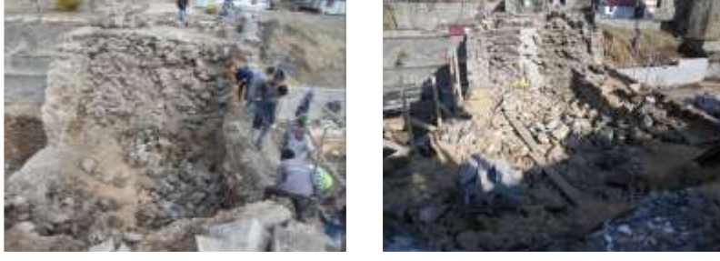
Şekil 14. Alemdar Köprüsü - Bitlis
