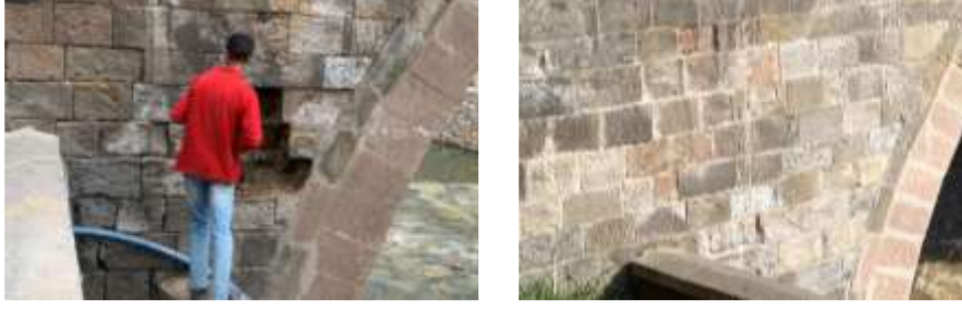
Şekil 20. Alemdar Köprüsü - Bitlis
