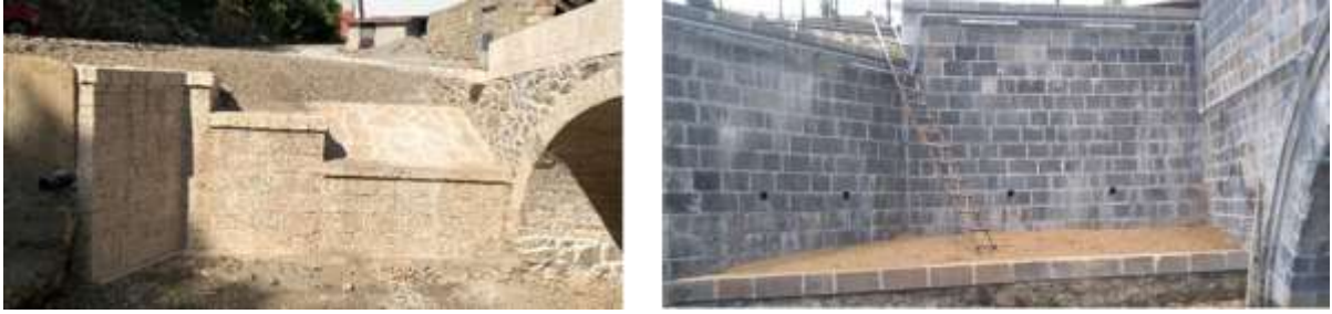
Şekil 15. Altınsu Köprüsü - Hakkari (Solda), Pamukçular Köprüsü – Bitlis (Sağda)
