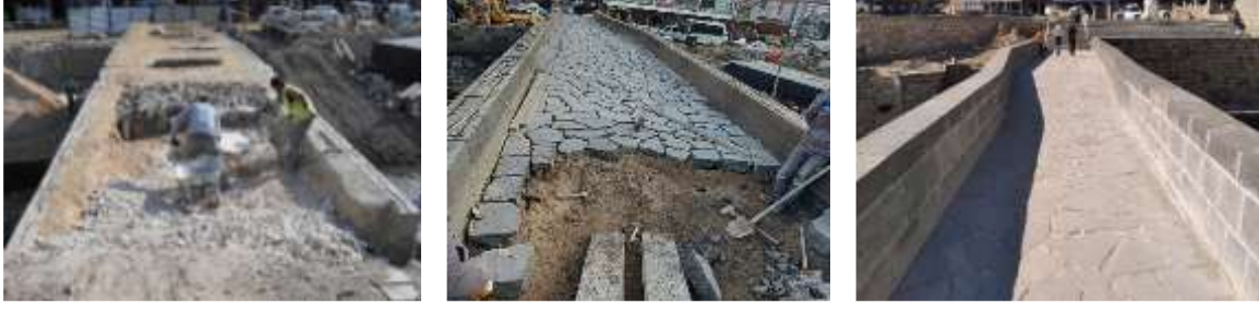
Şekil 16. Pamukçular Köprüsü - Bitlis
