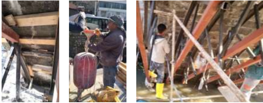
Şekil 21. Hatuniye Köprüsü - Bitlis
