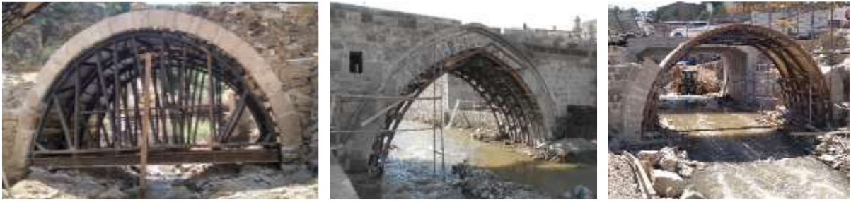
Şekil 7. Altınsu Köprüsü - Hakkari (Solda), Pamukçular Köprüsü - Bitlis (Ortada), Şerefiye II Köprüsü - Bitlis (Sağda)
