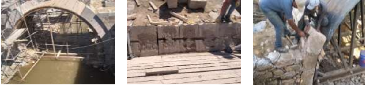
Şekil 13. Şerefiye II Köprüsü - Bitlis (Solda ve Ortada), Altınsu Köprüsü - Hakkari (Sağda)
