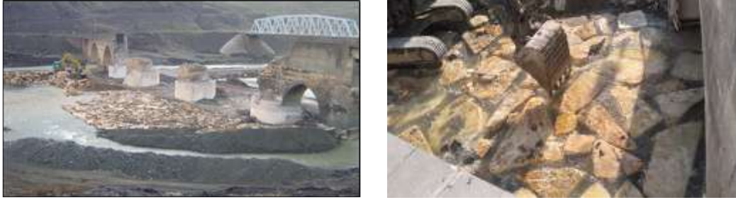
Şekil 11. Palu Köprüsü - Elazığ (Solda) ( Sert vd., 2009 ), Şerefiye II Köprüsü - Bitlis (Sağda)
