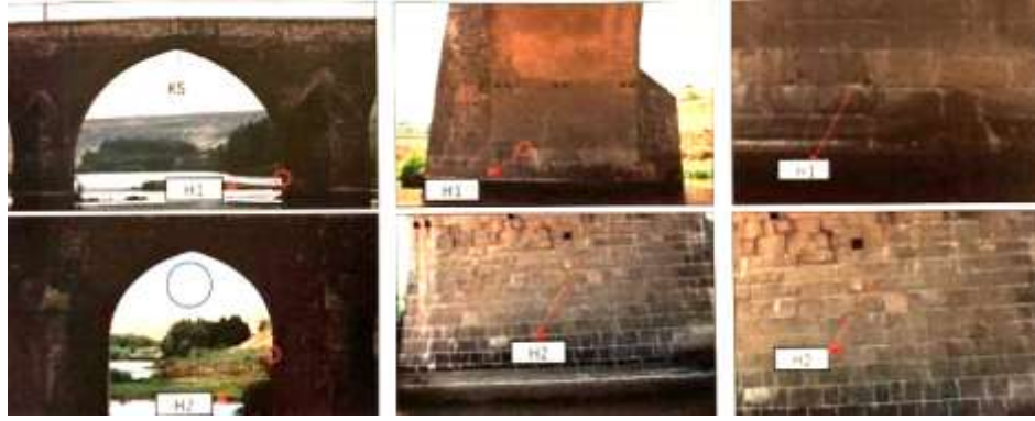
Şekil 4. Tarihi Dicle Köprüsü'nden (Diyarbakır) alınan H1 ve H2 orijinal harç numunelerinin köprü fotoğrafları üzerinde gösterimi ( Avşin vd., 2019 )
