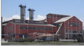
Foto 7. Küşpe Kurutma Binası
