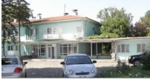
Foto 18. Ofis ve Lojman Binası
