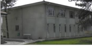
Foto 5. Pancar Muhasebe Binası
