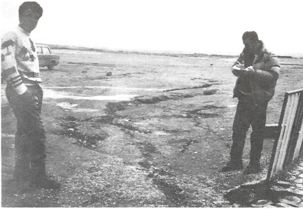
Şekil 11 Ekşisu Madensuyu tesislerinin yanındaki suni dolgu zeminde gelişen oturma yapıları ile ilgili yarıklar (çekim kuzeybatıdan güneydoğuya).
