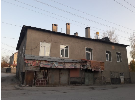
Şekil 19. Balkonlu bir geleneksel Van evi örneği (Akköprü mahallesi, Oğuzlar sokak)
