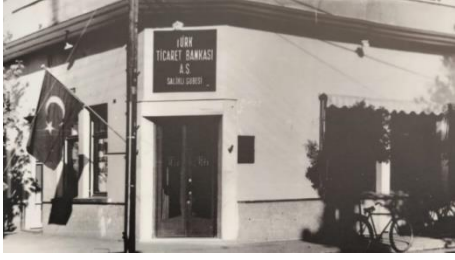
Salihli Şube Binası (ATİM Arşivi, 2024)
