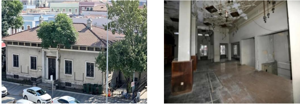
Şekil 15. Restorasyon Öncesinde Atıl Durumdaki Banka Binasının Dış ve İç Görünüşleri (Kaynak: Patronlar Dünyası, t.y.)
