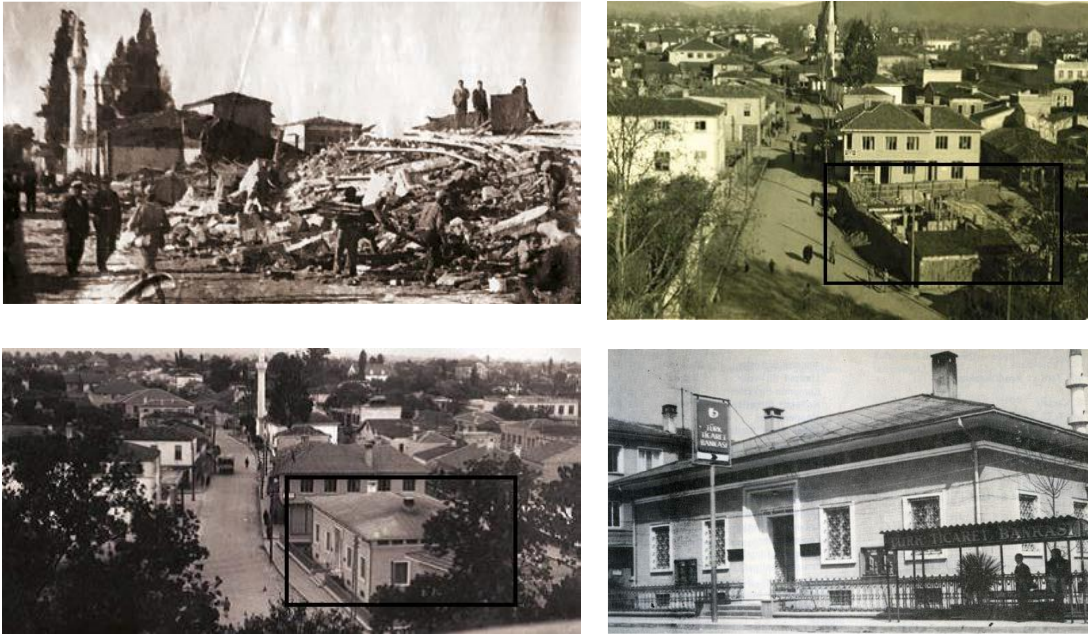
Şekil 12. 1943 Adapazarı Depreminde Enkaz Olan Banka Binası (1), 1947 Yılında Binanın Yeniden İnşasında Mevcut Temel Üstünde Başlatılan İlave Temel Çalışması (2), Yeniden İnşa Edilerek 1949'ta Hizmete Başlayan Banka Binası ve Yakın Çevresi (3-4) (Sarı ve Narin, 2021)
