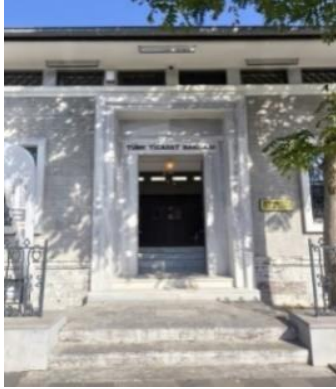
Şekil 13. Bankanın Giriş Kapısı (Yazarlar, 2024)
