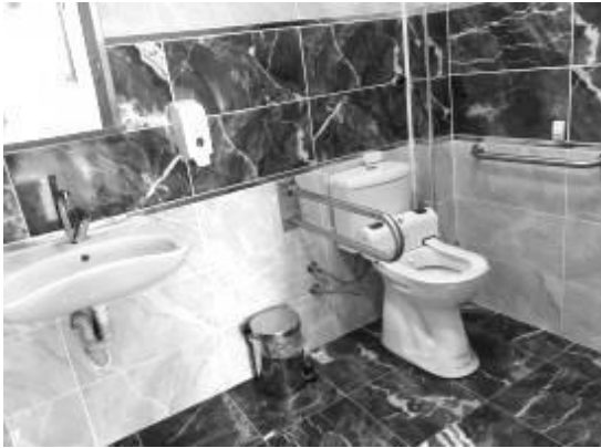
Şekil 6. Giriş kat engelli tuvaleti
