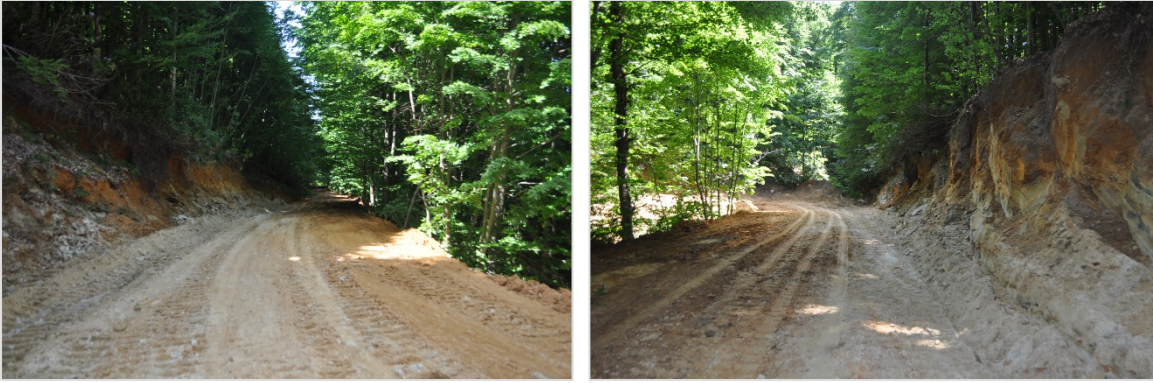
Şekil 3. Buldozer ile yol seviyesinin düzeltilmesi
