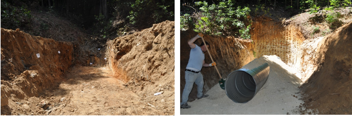
Şekil 4. Menfez yerlerinin açılması ve menfezin yerleştirilmesi
