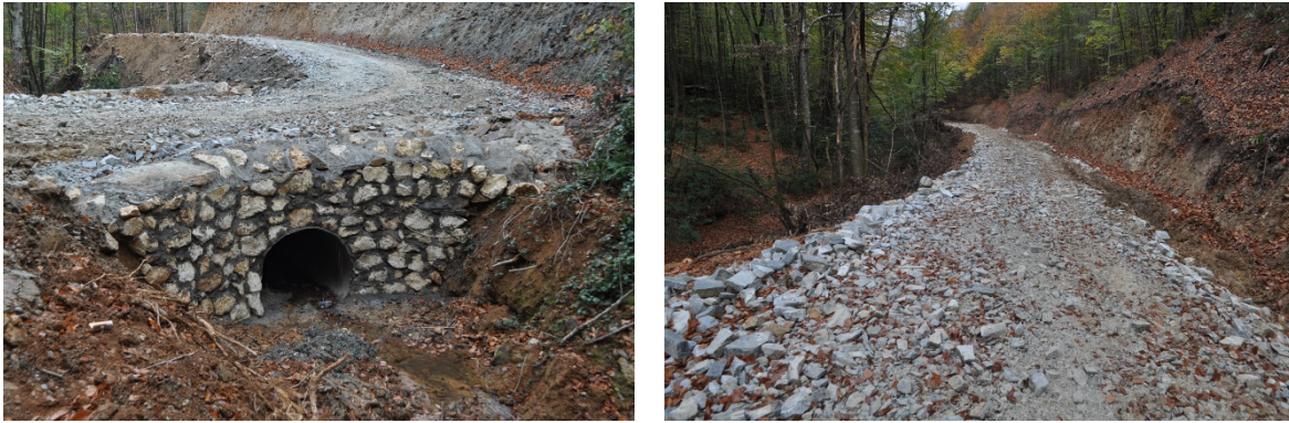
Şekil 5. Menfez baş duvarlarının yapımı ve üst yapı çalışmaları
