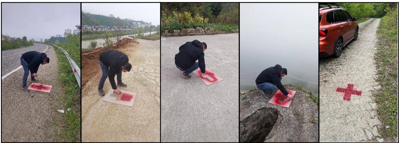
Şekil 4. Çalışma alanında yer kontrol noktalarının (YKN) sahaya yerleştirilmesi süreci. Farklı zemin türlerinde şablon ve sprey boyası kullanılarak oluşturulan işaretlemeler GNSS ölçümleri öncesinde belirlenmiştir
