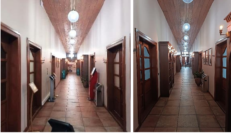
Şekil 28. Alt Kat Koridor Doğu ve Batıdan Genel Görünüm (Yazara Aittir: 2025).
