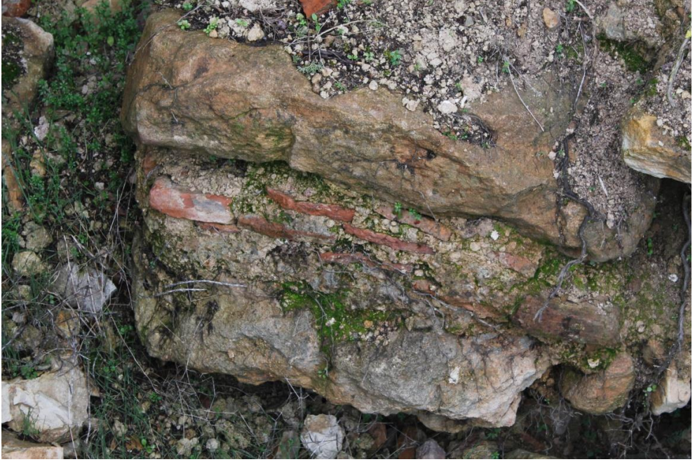
Görsel-19-Arapuçtu Gözetleme Kulesi Kalıntıları
