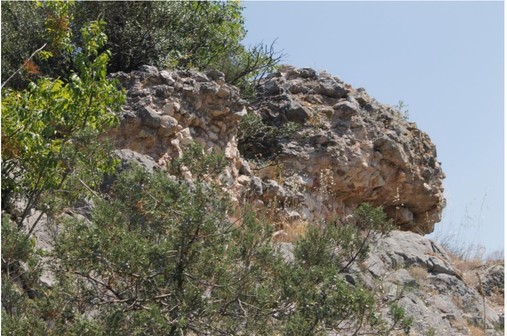
Görsel-12-Çadırılı Hisarı Duvar Detayı
