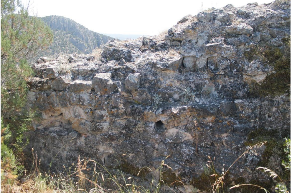
Görsel-13-Çadırılı Hisarı Duvar Detayı
