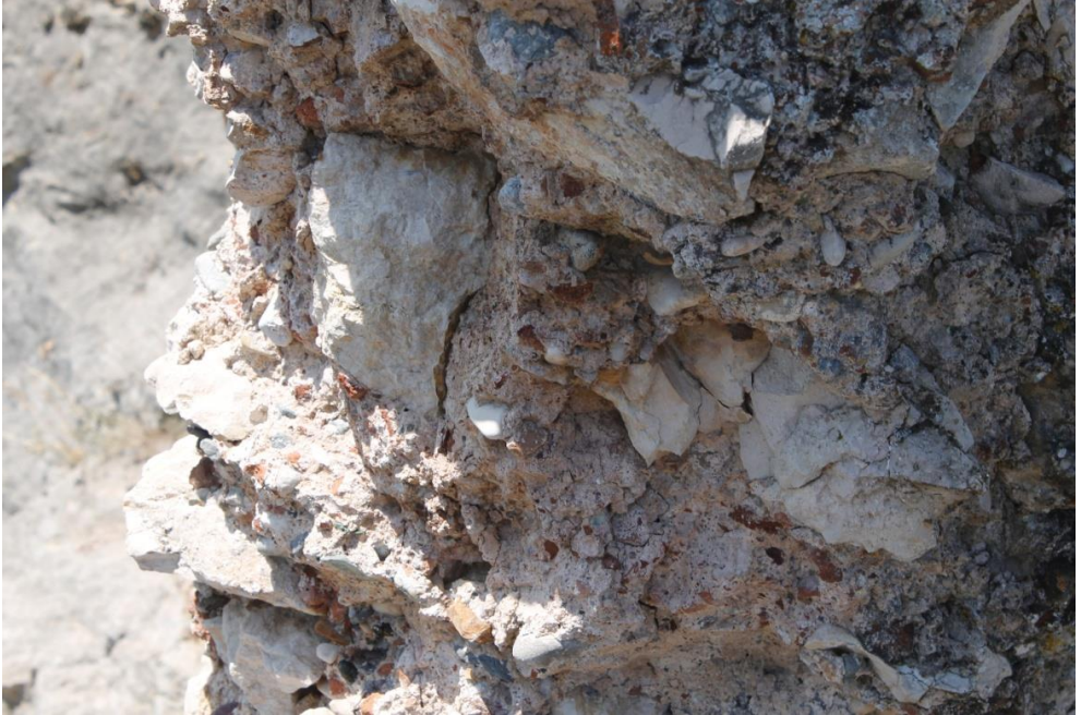
Görsel-14-Çadırılı Hisarı Duvar Harç Detayı
