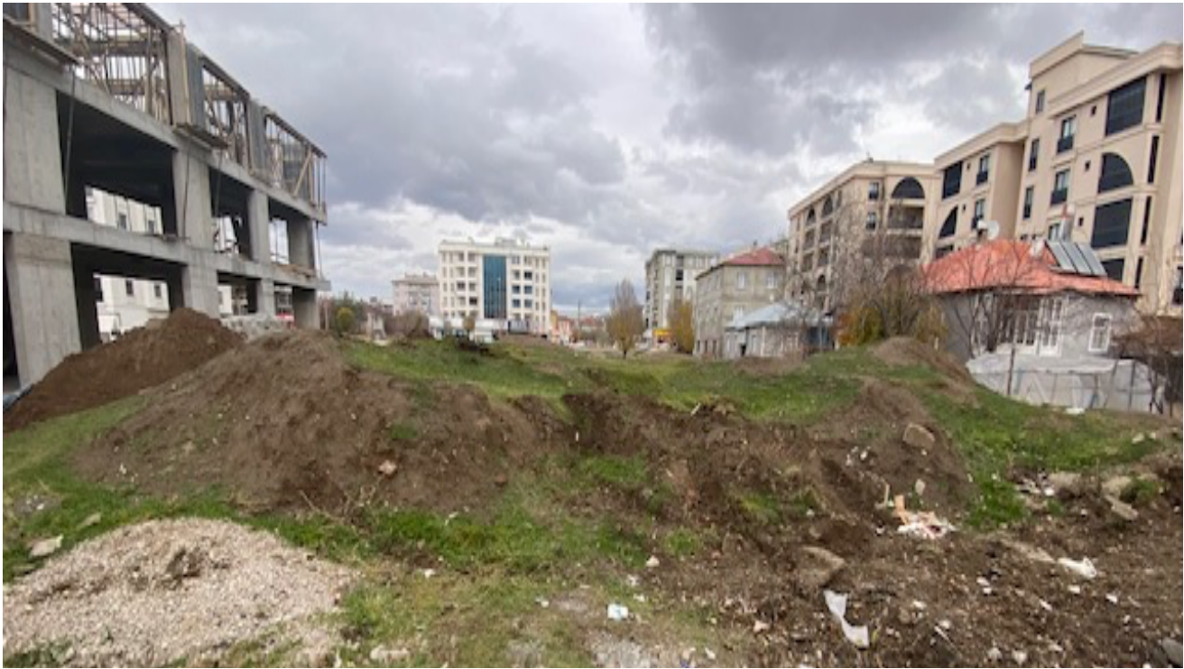
Şekil 12. Tahir Paşa Konağı Günümüz Yıkık Genel Görünüşü (Kaynak: Ş. Öztürk, 2024)
