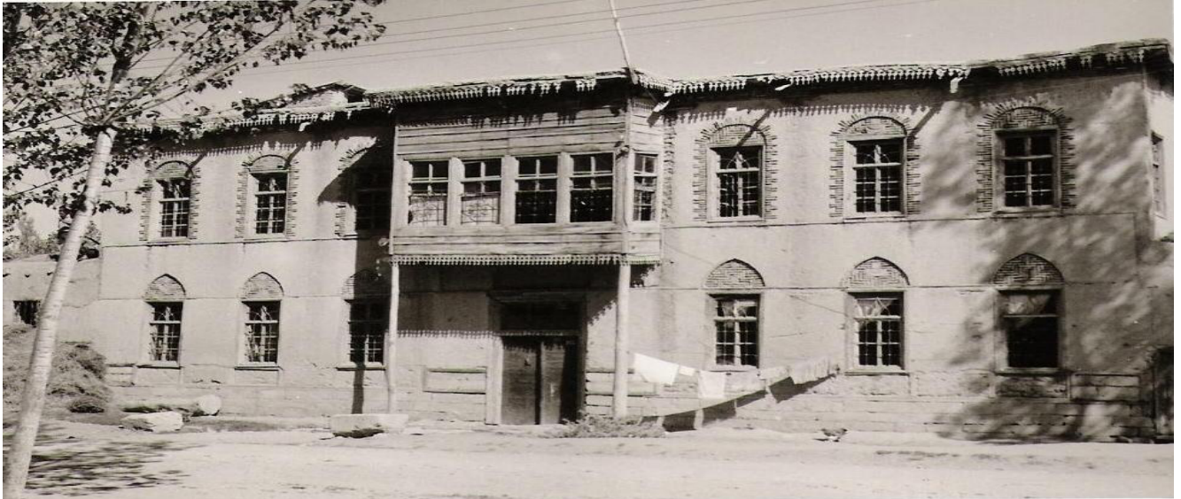
Şekil 17. Tahir Paşa Konağı Güney Görünüşü (Kaynak: VKVKBKM Arşivi, 2020)
