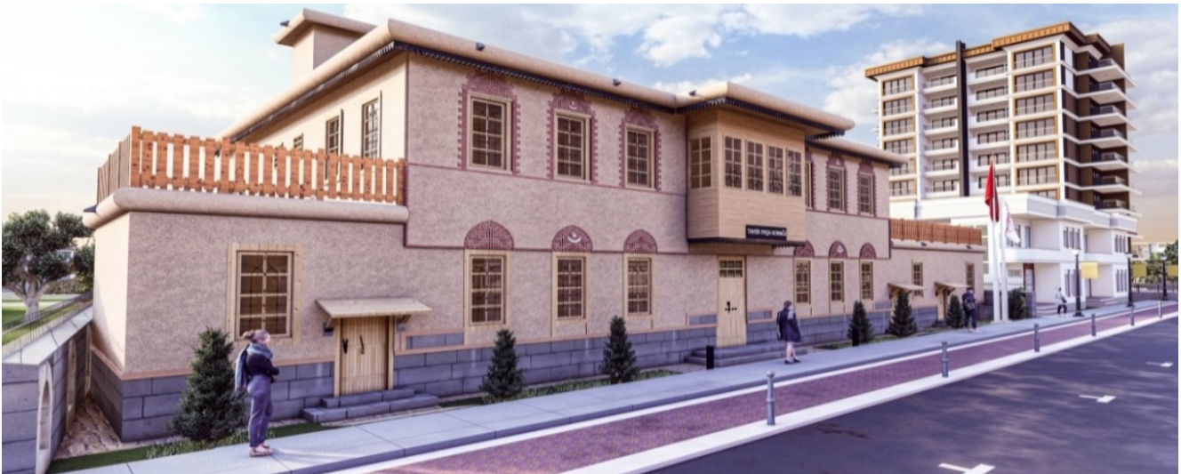
Şekil 47. Tahir Paşa Konağı Güneybatı Görünüşü (Kaynak: A.Y. Öztürk, 2024)
