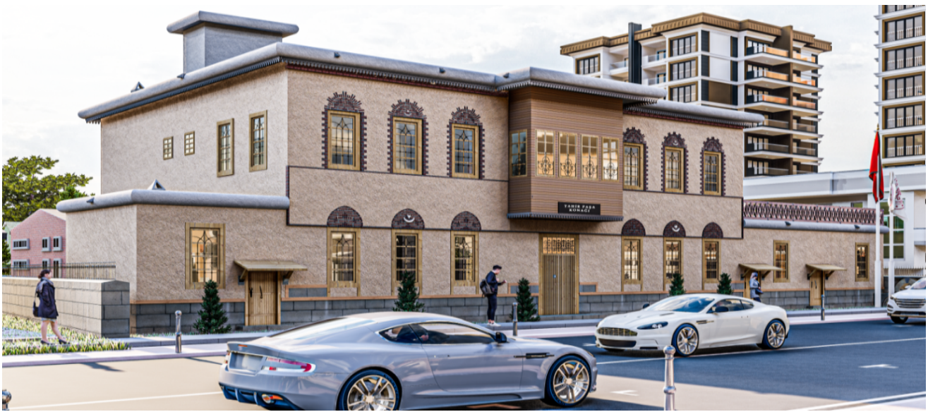
Şekil 48. Tahir Paşa Konağı Güneybatı Görünüşü (Kaynak: A.Y. Öztürk, 2024)
