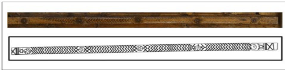
Fotoğraf 26; Çizim 24: Kapı binisi detay görünüş ve çizimi.
