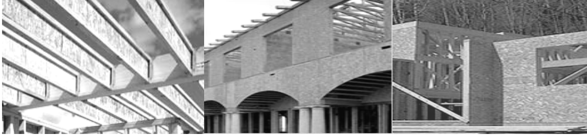
Resim 2. Prefabrik odun kökenli yapı malzemelerinin yapı üzerine eklenmesi.
