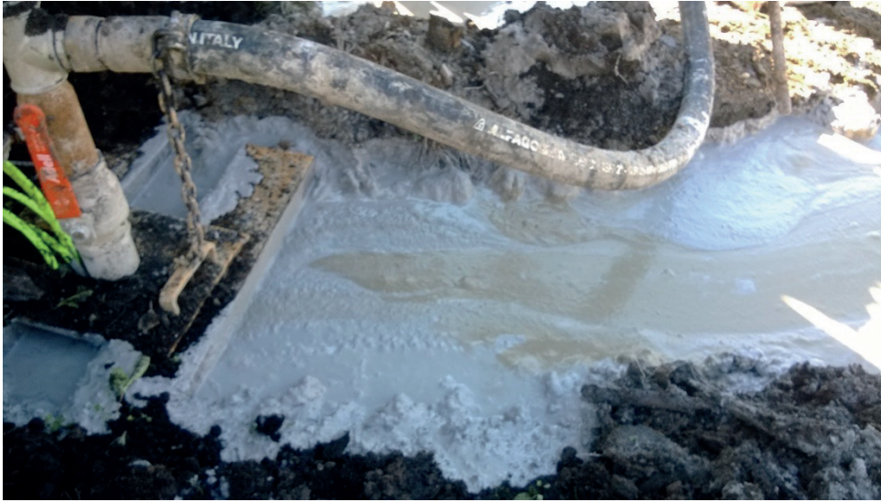
Şekil 3: Bentonit çamuru ile dolu kuyunun çimento şerbeti ile doldurulması, çimentonun yüzeye çıkması Figure 3: Filling the well filled with bentonite mud with cement grout, bringing the cement to the surface
