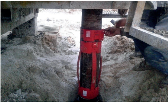
Şekil 5: Merkezleyicinin muhafaza borusuna bağlanması Figure 5: Connection of the centralizer to the casing tube
