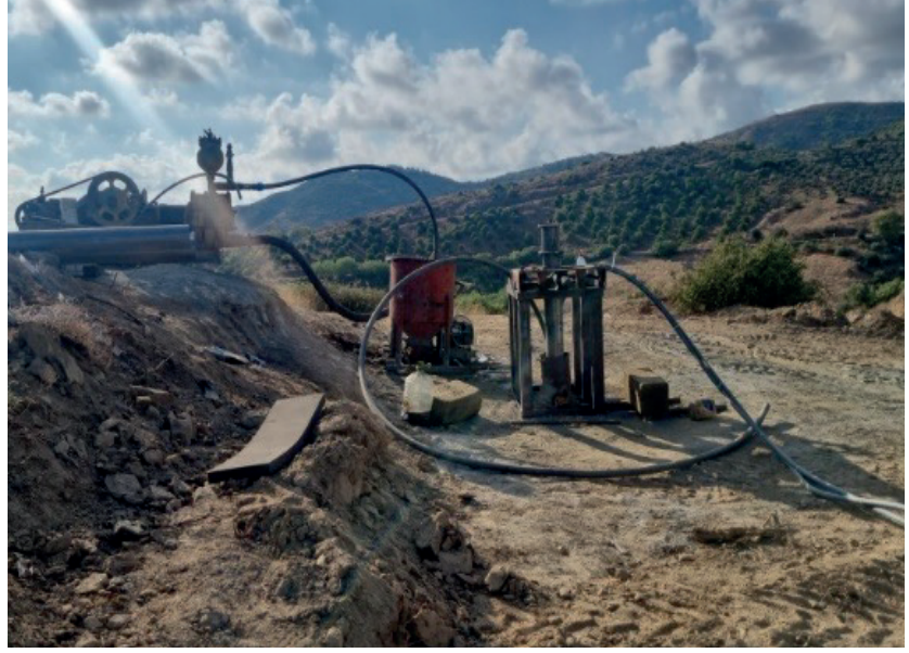
Şekil 7: Muhafaza borusu ile kuyu cidarı arasındaki boşluğun, yüzeyden indirilen plastik borular kullanılarak çimentolanması Figure 7: Cementing the space between the casing and the well wall using plastic pipes lowered from the surface
