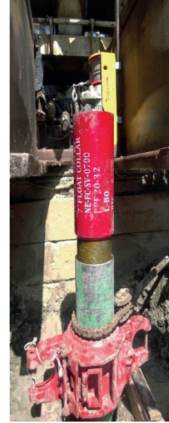
Şekil 4: Yüzdürme Kılavuzu ve Yüzdürme Yakası ekipmanlarının kuyuya indirilen ilk boruya eklenmesi
