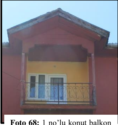
Foto 68: 1 no'lu konut balkon detayı
