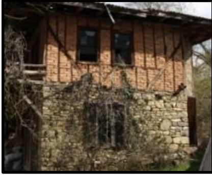
Foto 6: 10 no'lu konut yan cephe Ağaköy
