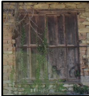
Foto 12: 10 no'lu konut pencere kepenği, Ağaköy
