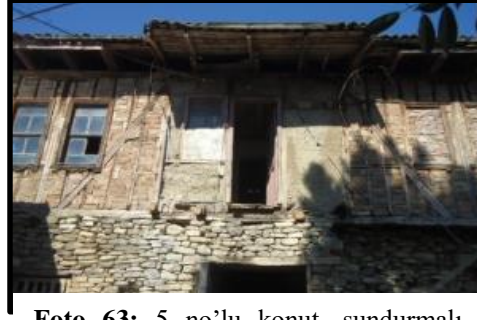
Foto 63: 5 no'lu konut, sundurmali kırma çatı detayı
