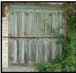
Foto 11: 9 no'lu konut pencere kepenği, Ağaköy
