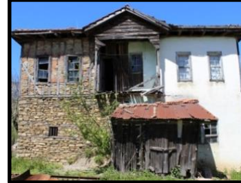
Foto 22: 8 no'lu konut yan cephe, Ağaköy
