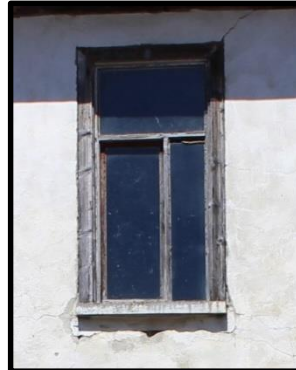
Foto 56: 3 no'lu konut ön cephe penceresi
