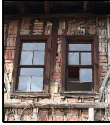
Foto 58: 4 no'lu konut arka cephe penceresi
