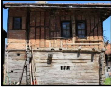
Foto 9: 6 no'lu konut yan cephe, Ağaköy
