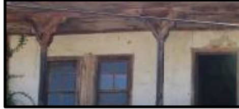
Foto 66: 4 no'lu konut, balkon detayı
