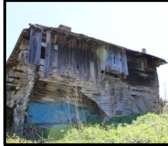
Foto 10: 7 no'lu konut, yan cephe, Ağaköy
