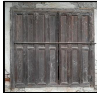
Foto 13: 11 no'lu konut pencere kepenği, Ağaköy
