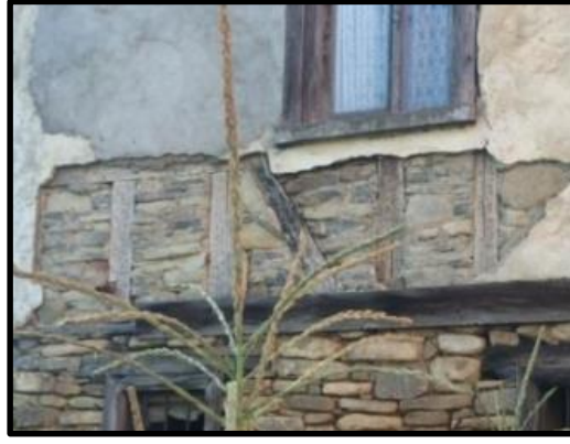
Foto 5: 3 no'lu konut duvar detayı, Ağaköy
