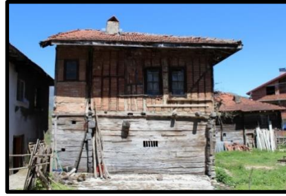
Foto 61: 6 no'lu konut, üç yüzeyle kırma çatı örneği
