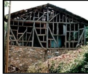
Foto 76: Cumalıkızık (Perker, Akıncıtürk,2011:43)
