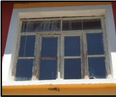
Foto 55: 1 no'lu konut ön cephe penceresi
