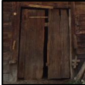
Foto 38: 7 no'lu giriş kapısı
