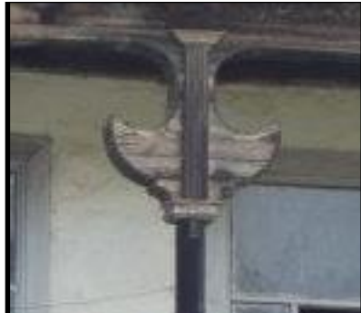
Foto 67: 3 no'lu konut, balkon detayı
