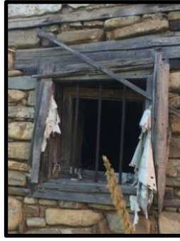
Foto 54: 3 no'lu konut arka cephe penceresi
