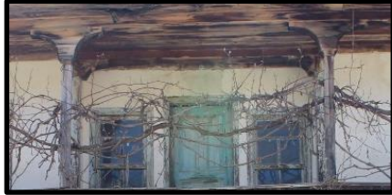
Foto 65: 2 no'lu konut, balkon detayı
