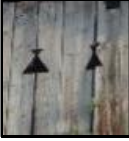
Foto 52: 6 no'lu konut yan cephe
