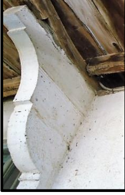
Foto 32: 2 no'lu konut konsol detayı
