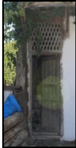
Foto 50: 8nolu konut giriş kapısı
