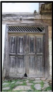
Foto 45: 8 no'lu konut giriş
