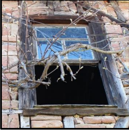
Foto 57: 2 no'lu konut yan cephe penceresi
