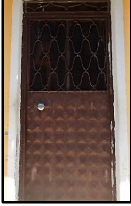
Foto 14: 1 no'lu konut giriş kapısı, Ağaköy
