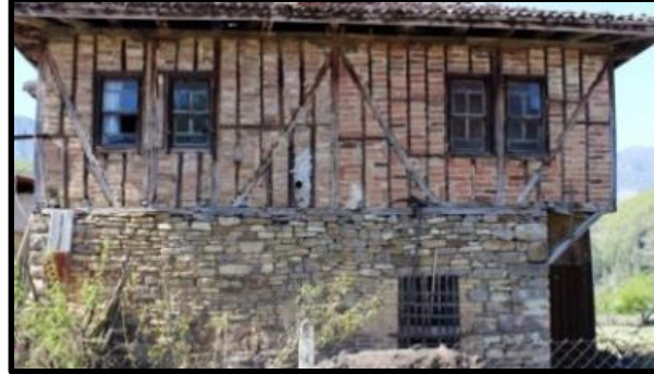
Foto 7: 5no'lu konut yan cephe Ağaköy
