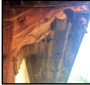
Foto 34: 3 no'lu konut konsol detayı
