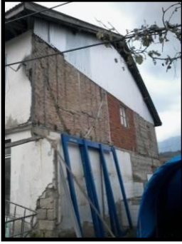
Foto 59: 11 no'lu konut, beşik çatı örneği
