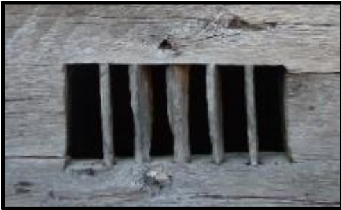
Foto 51: 6 no'lu konut yan cephe penceresi
