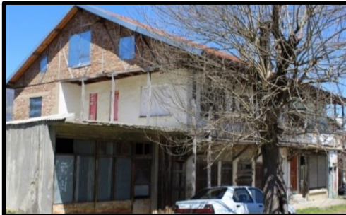
Foto 26: 11 no'lu konut yan cephe, Ağaköy
