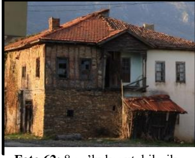
Foto 62: 8 no'lu konut, bileşik kırma çatı örneği
