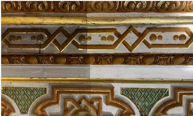
Görsel 7. Temizlik Öncesi ve Sonrası Ahşap Tavan Duvar Kesişim Yeri Silmelerinin Durumu.
