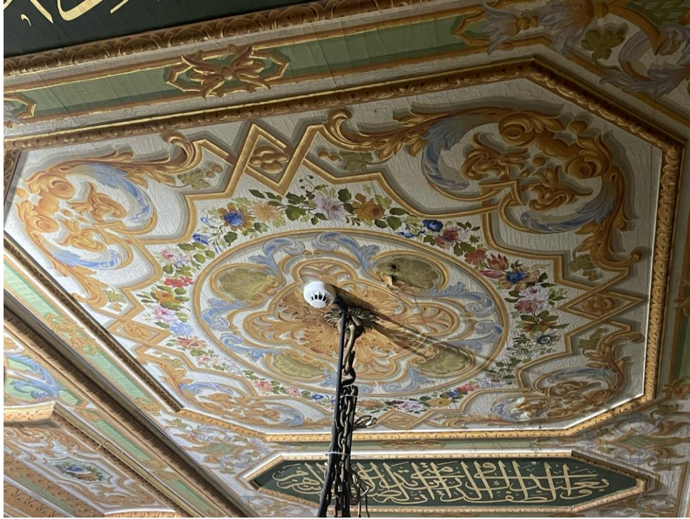
Görsel 8. Tavan Merkezinde Yer Alan Pasa Ahşapları Arasındaki Tuval Paftasında Kabarmış Olan Desen ve Renkli Kalemî Uygulaması.
